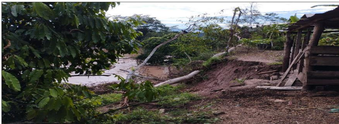
FIGURA N°03: TRAMO CRÍTICO EN EL RÍO SAPOSOA, DONDE SE PRODUJO SOCAVAMIENTO DE LA RIBERA GENERANDO LA CAIDA DE ARBOLES, AFECTANDO A LAS VIVIENDAS ALEDAÑAS Y ÁREAS ADE CULTIVO.
