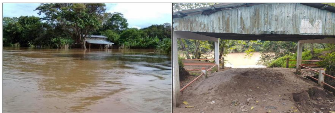
FIGURA N°02: TRAMO CRÍTICO EN EL RÍO SAPOSOA, MIRADOR Y PUERTO CANTORCILLO INUNDADO EN TIEMPOS DE MAXIMAS AVENIDAS, Y POR LA VELOCIDAD DEL AGUA VIENE EROSIONANDO EL TALUD DE LA RIBERA.
